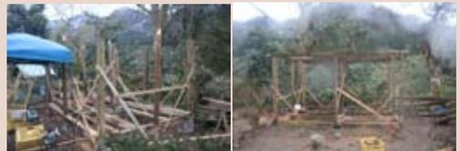
雪が降る中、1本ずつ長さ・幅が異なる材を角ノミとホゾ取りを使って、柱・梁・桁…と取り付けていく。1本と同じ規格がない廃材を使いこなすのは、臨機応変と思いつき。材料が揃っているのと違って、思うようにいかないのを乗り越えていくのが面白い！
